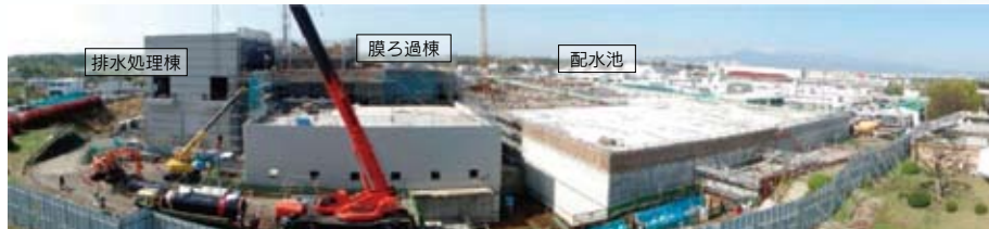
川井浄水場再整備事業現場(平成24年4月現在)
