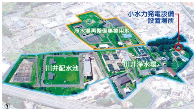
川井浄水場及び再整備事業用地
